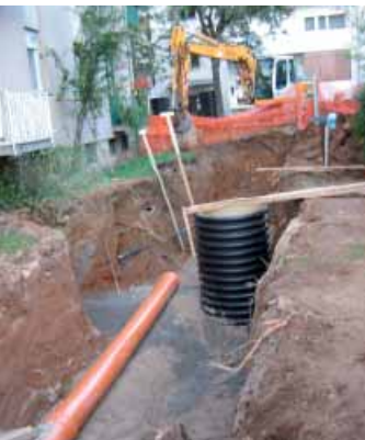
gradnja kanalizacije na Kidričevi (foto ML Božič)
