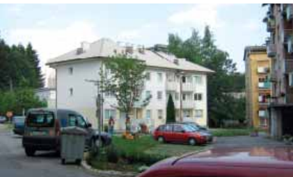
nov blok na križišču Gradnikove in Levstikove ulice - (foto Zena)
